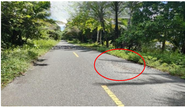
Gambar 2. Jenis kerusakan retak buaya pada STA. 17+275
