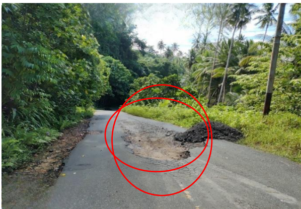
Gambar 2. Jenis kerusakan retak buaya pada STA. 17+275
