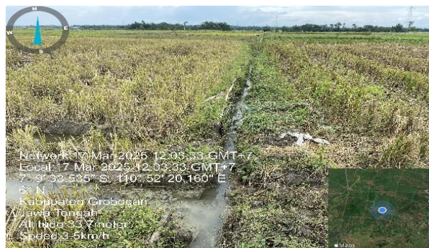
Gambar 1. Kondisi Saluran Eksisting
